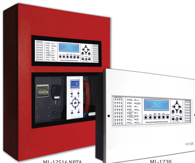
ML-12516.NPTA Réseau de Panneau d'alarme incendie, imprimante, téléphone et modules d'annonce inclus
